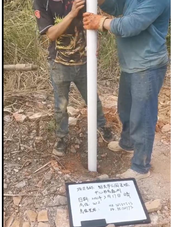
W2 地下水监测井下管
