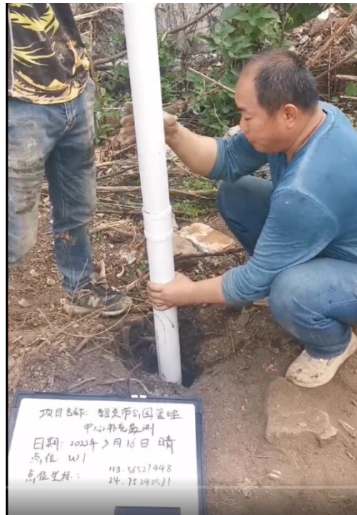
W1 地下水监测井下管
